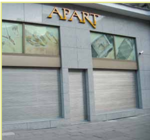
Schaufenster mit einbruchhemmenden Rollläden
